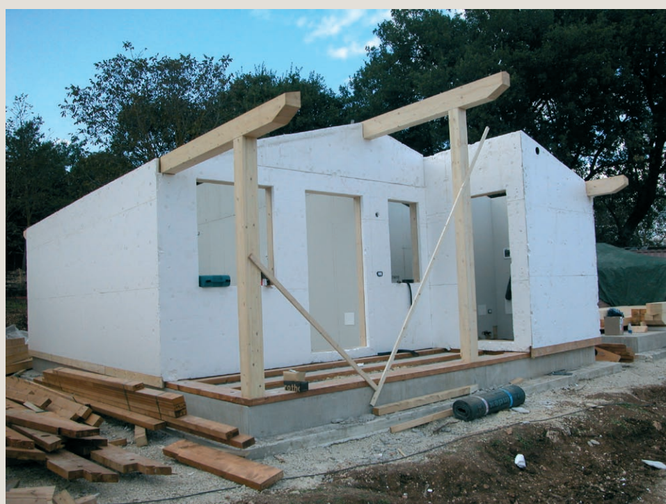
2) Fine montaggio struttura
